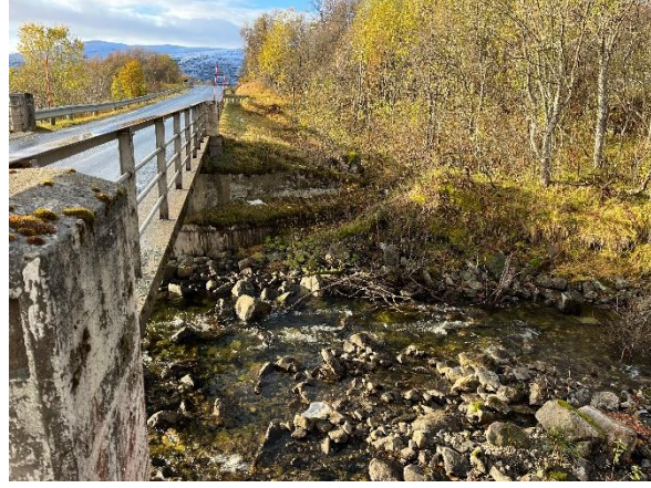
Figur 2-3. Dagens bru sett fra nordøst.
