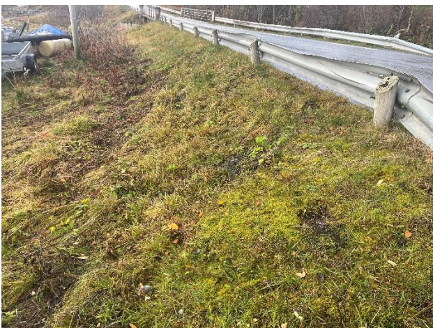
Figur 4-16: Grøftkant sørøst for brua
